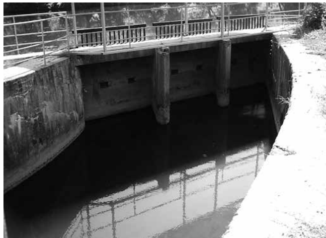
Slika 1. Postojeći zahvatni objekat na rijeci Bosni za potrebe TE Kakanj
